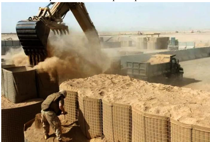
На фото видны два размера габиона
