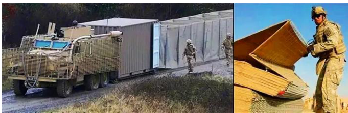
На фото видны два размера габиона
